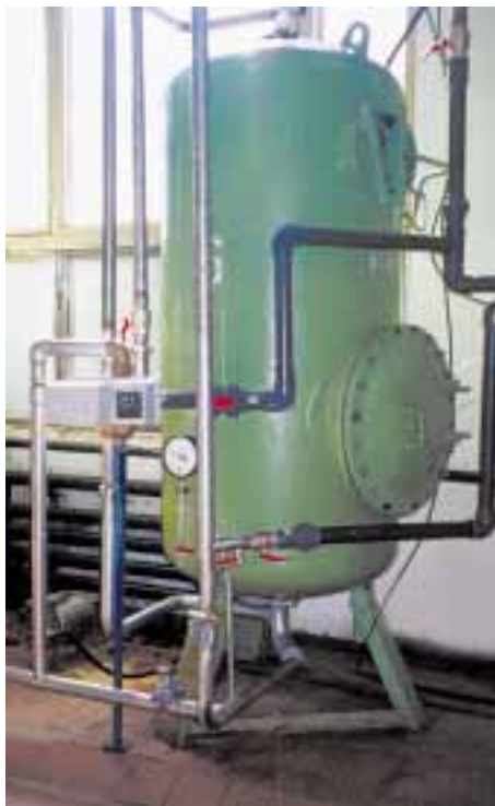
Рис. 2. Модернизированный фильтр с блоком автоматического управления
